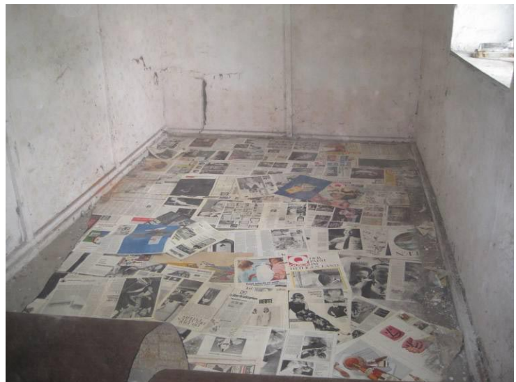
Abb. 29: Kopfbau OG Raum 1.9: Stragula-Belag auf Zeitungen von 1958/59 ausgelegt
