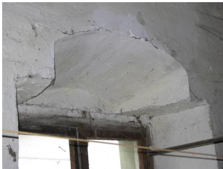
Abb. 26: Kopfbau: historischer Sturz und dessen Verbreiterung der 1940er Jahre
