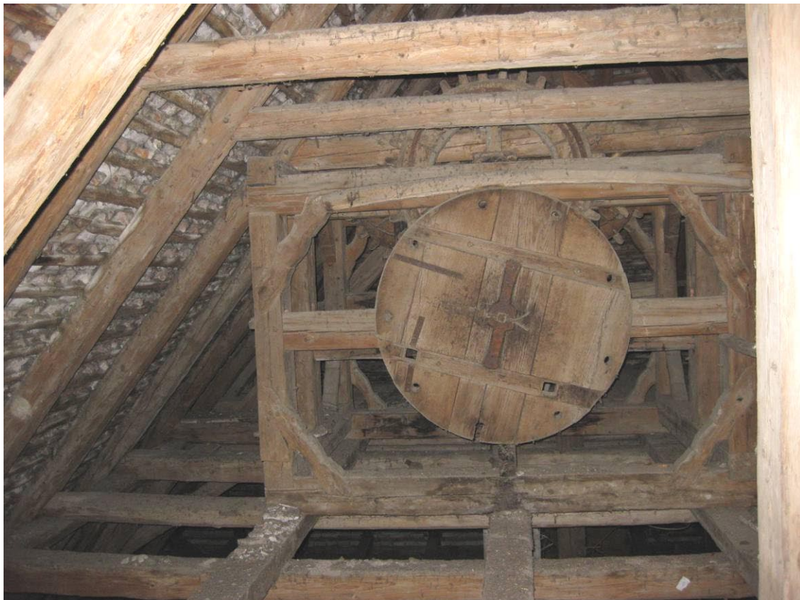
Abb. 46, 47: Kopfbau: barocke Seilwinde im Dachwerk (dendrochronologisch datiert 1682)
