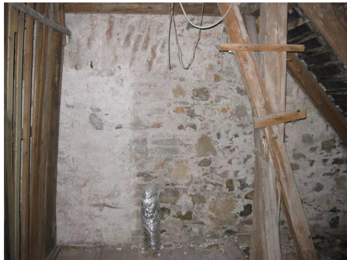
Abb. 58, 59: Nordbau DG: links: Brandschutztüre (neuzeitlich hintermauert); rechts: bauzeitliche, zugesetzte Türöffnung
