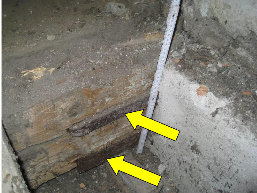
Abb. 20: Kopfbau Nordwand: Anbindung Deckenbalken ü. OG am Mauerwerk (oben: Eisenschlauder, unten: U-Profil)
