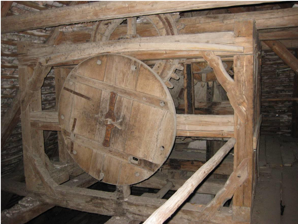
Abb. 46, 47: Kopfbau: barocke Seilwinde im Dachwerk (dendrochronologisch datiert 1682)
