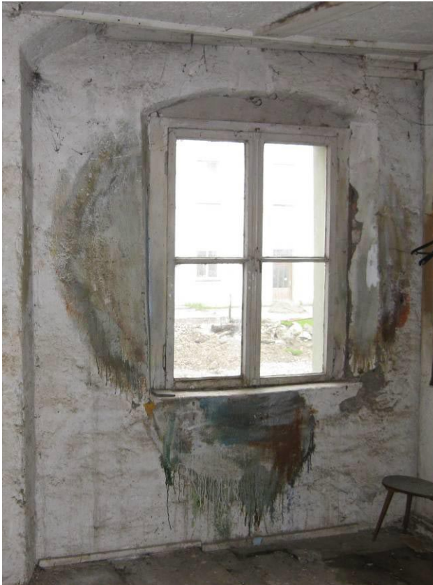
Abb. 24, 25: Kopfbau: Einfachfenster 1940er Jahre
