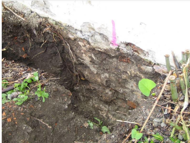
Abb. 12: Fundamentmauerwerk
