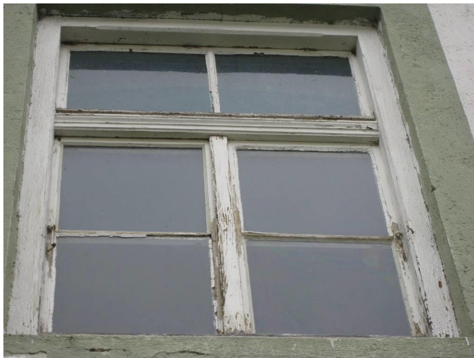
Abb. 51: Südbau Fenster OG Westseite
