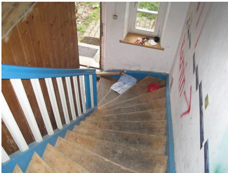
Abb. 32: Nordbau: Treppe EG-OG
