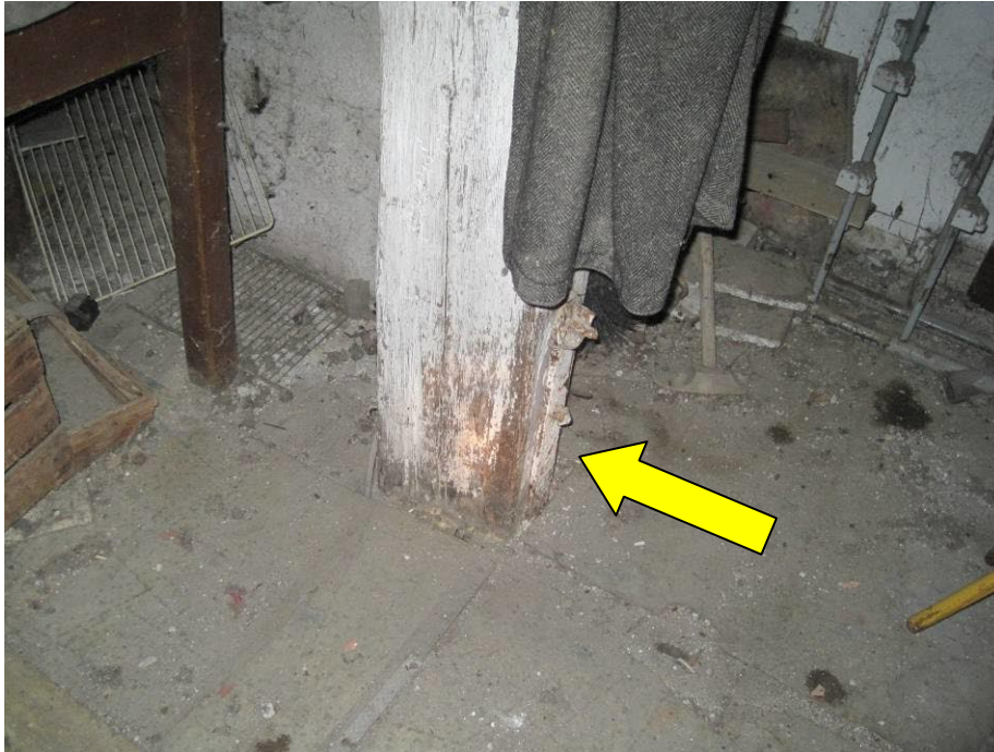
Abb. 18: Kopfbau: intakter Fußpunkt der östl. Hängesäule
