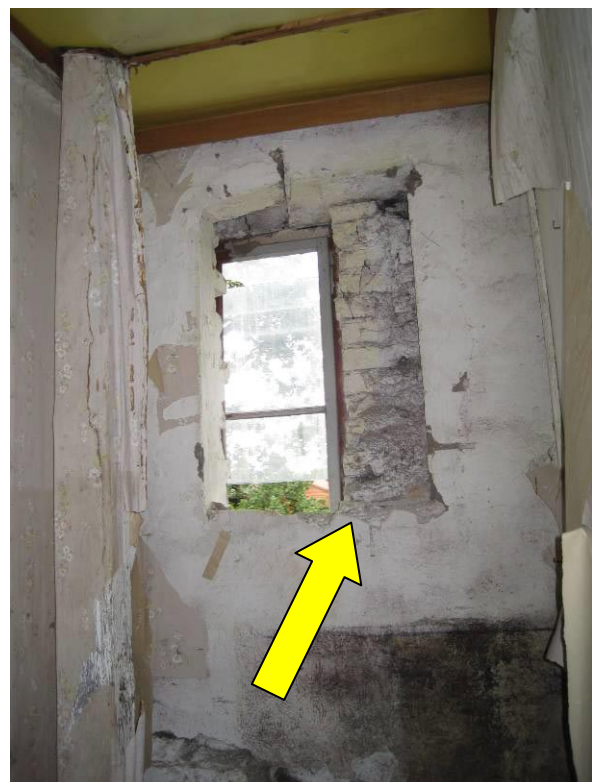
Abb. 42: Kopfbau OG Raum 1.10: Mittiges Fenster Westseite: Seitl. Verbreiterung mit nachträgl. Ausmauerung
