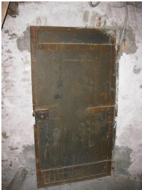
Abb. 58, 59: Nordbau DG: links: Brandschutztüre (neuzeitlich hintermauert); rechts: bauzeitliche, zugesetzte Türöffnung
