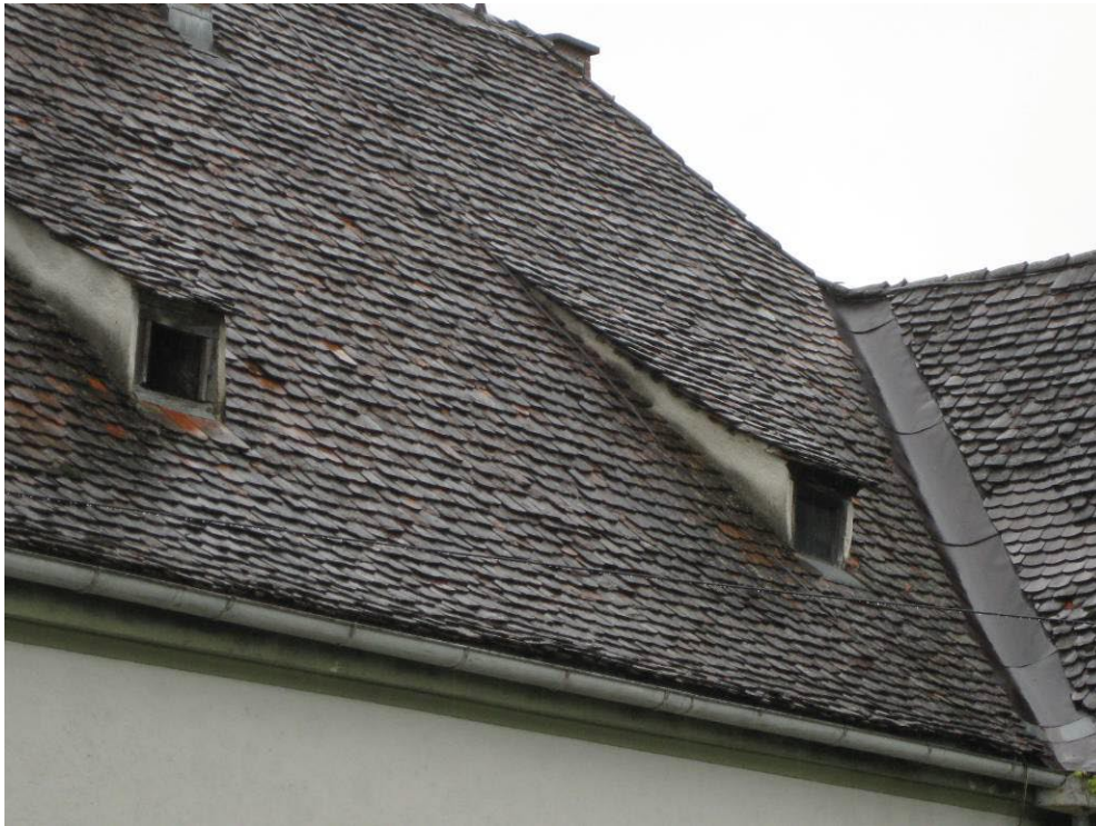
Abb. 50: Kopfbau Südseite: Dachhaut mit Schleppgauben
