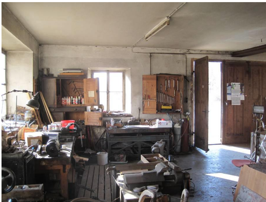
Abb. 15: Betonestrich / Holzbretterboden EG Kopfbau (Werkstatt)
