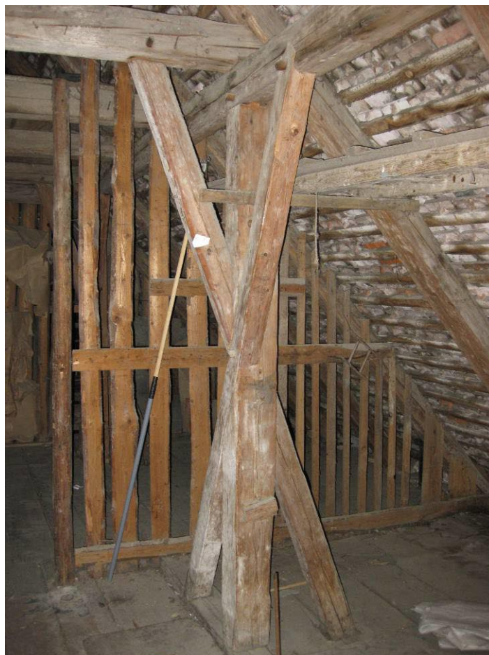
Abb. 21: Dachwerk Nordbau: stehender Stuhl mit raumhohen Auskreuzungen des Bindergespärres
