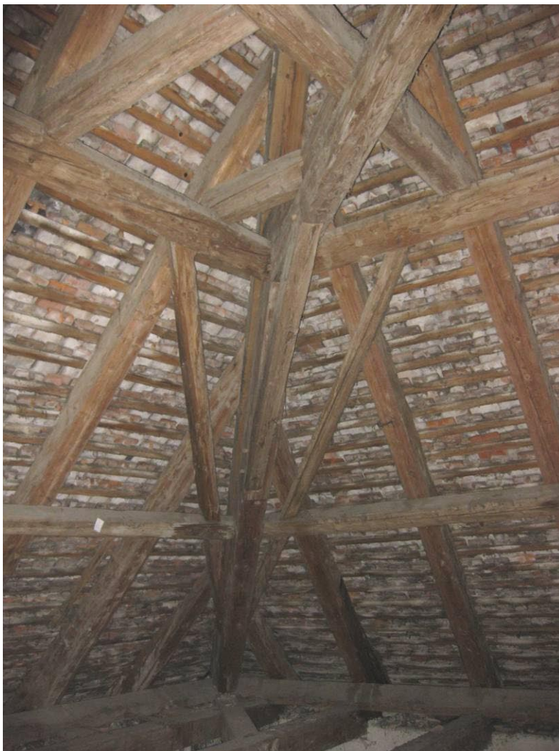
Abb. 48: Kopfbau: Walmausbildung im Dachwerk (dendrochronologisch datiert 1757-1760)
