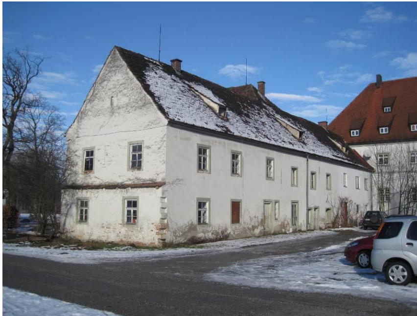
Abb. 22: Ansicht Südost: durchlaufende Dachfläche
