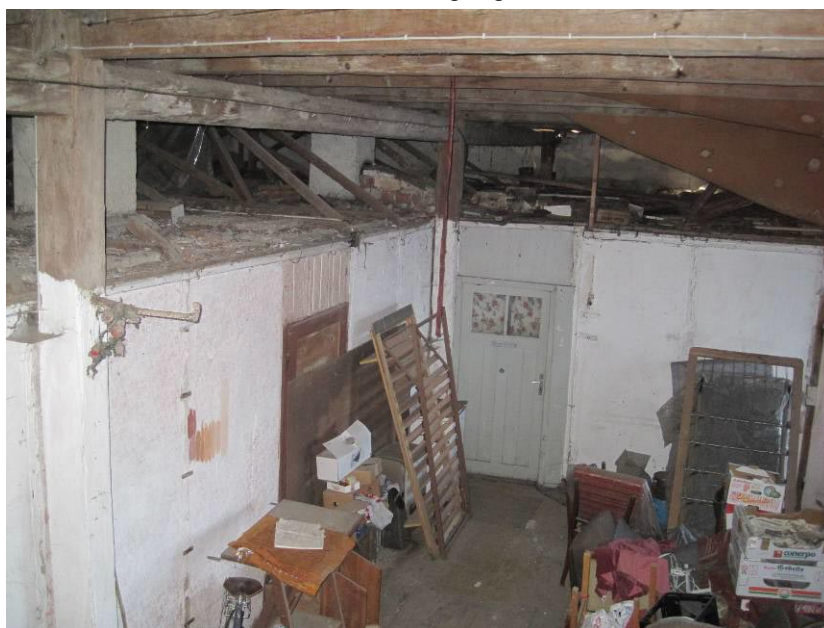
Abb. 13: Leichtbauwände OG Kopfbau
