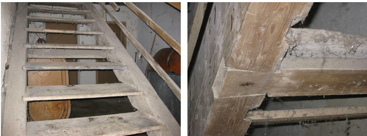
Abb. 39, 40: Kopfbau Raum 0.4: Treppe EG-OG
