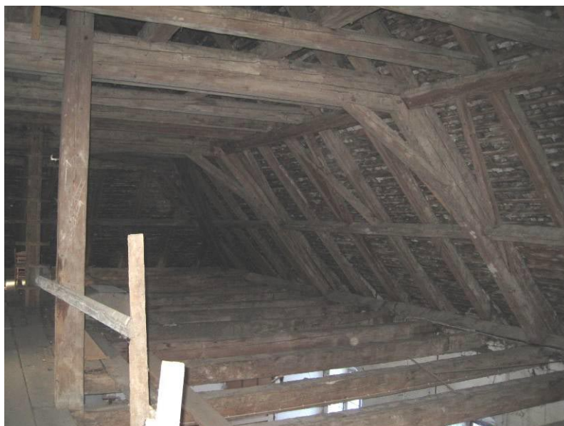
Abb. 17: Blick in den Dachraum des Kopfbau
