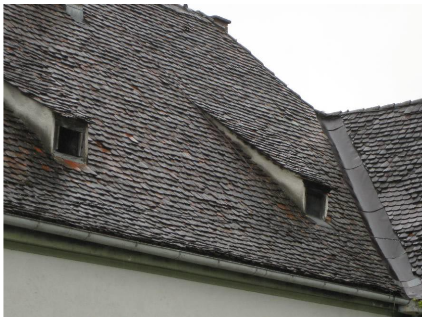
Abb. 23: Kopfbau: südseitige Dachhaut mit Schleppgauben
