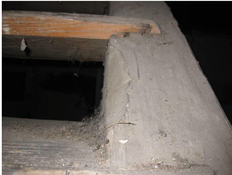
Abb. 41: Kopfbau Raum 1.1: Treppe OG-DG, Detail geschweifte Kehlung
