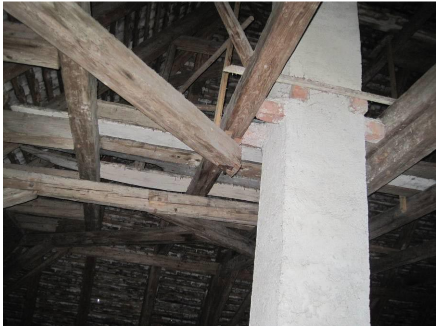
Abb. 30: Kopfbau DG – westlich eingestellter Kamin mit Auswechslung
