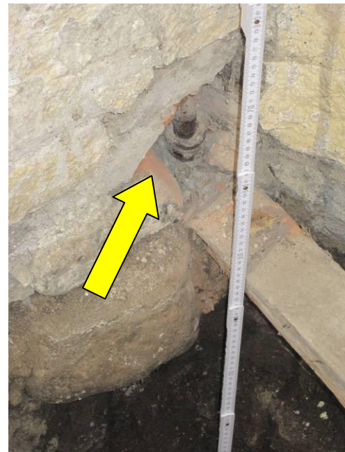
Abb. 34, 35: Kopfbau Ost: ehem. Eingangstor / Türangel
