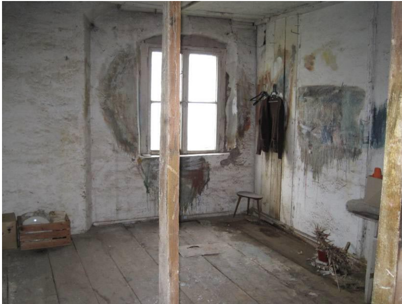
Abb. 16: bauzeitlicher Bohlenbelag OG Kopfbau
