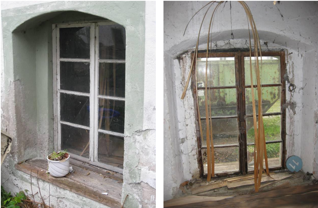
Abb. 37, 38: Kopfbau: ältestes Fenster innen- und außen
