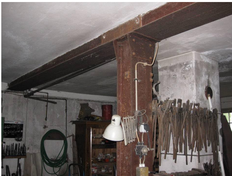
Abb. 19: Kopfbau Werkstatt: Stahlstütze u. -unterzug anstelle Holzbalken
